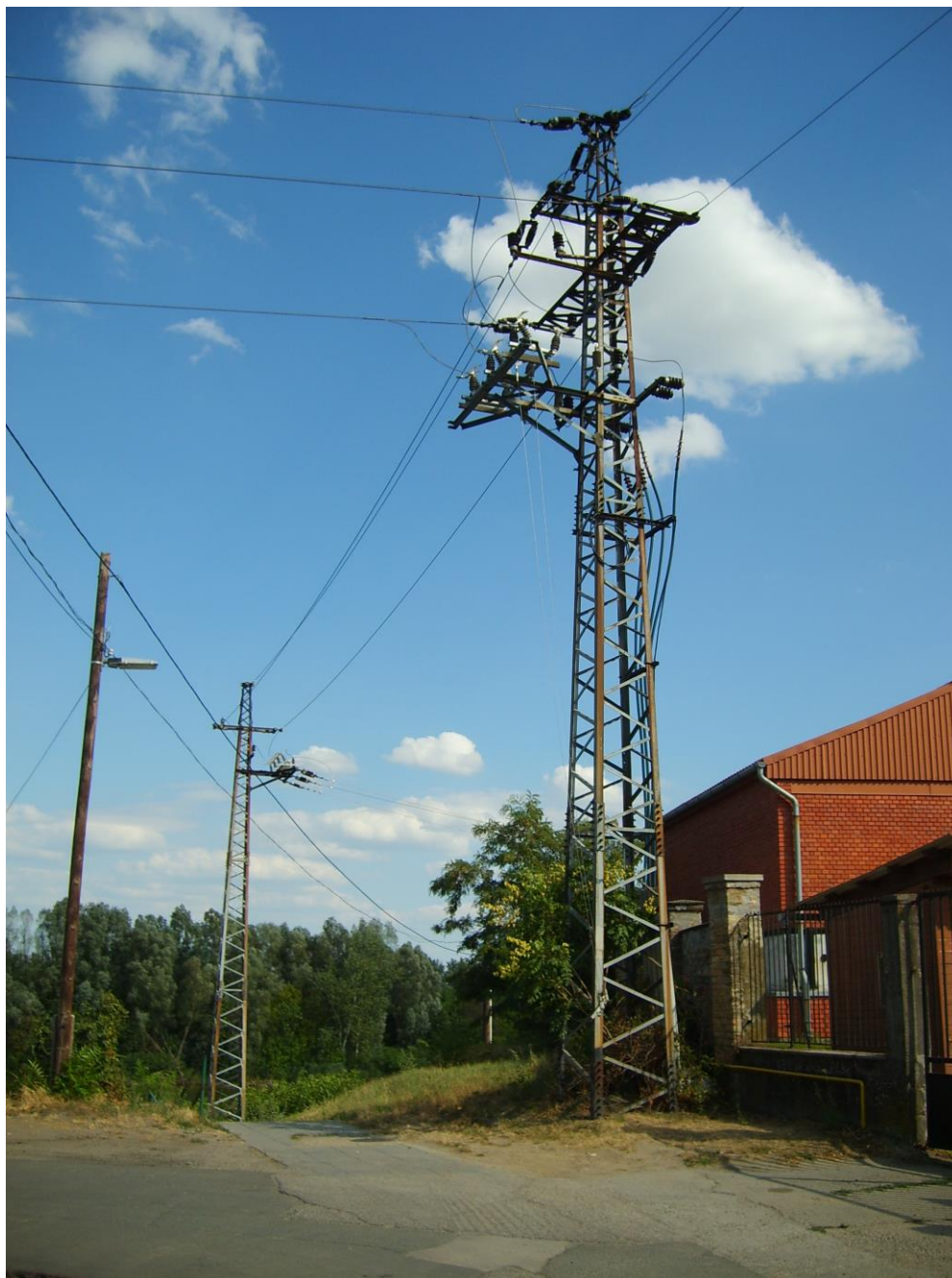
A tolnai előjáróság által 1938-ban kifogásolt nagyfeszültségű vezeték kiindulási pontja a Selyemgyár északi oldalánál
